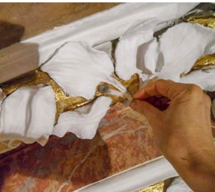
Detail odpadávání pozlacení od podkladu
