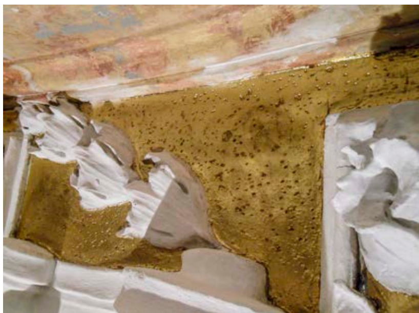
Detail poškození zlaceného povrchu
