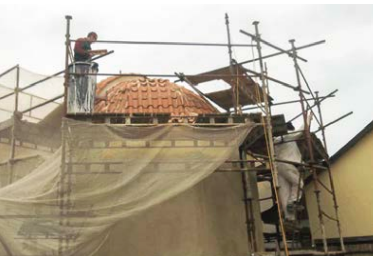
Pokládání prejzové krytiny na klenbovou střechu kaple
