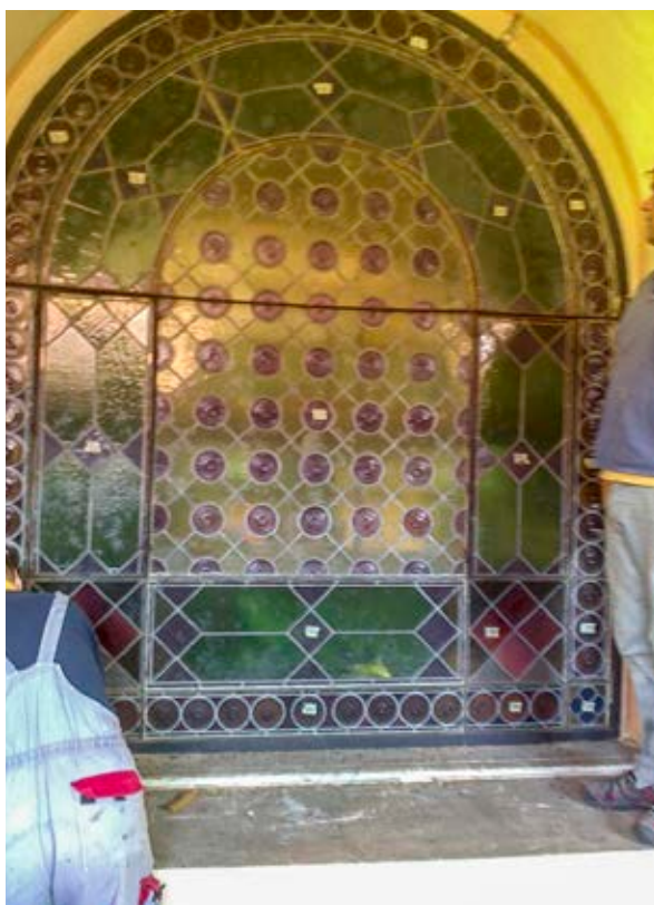
Vitráž před demontáží
