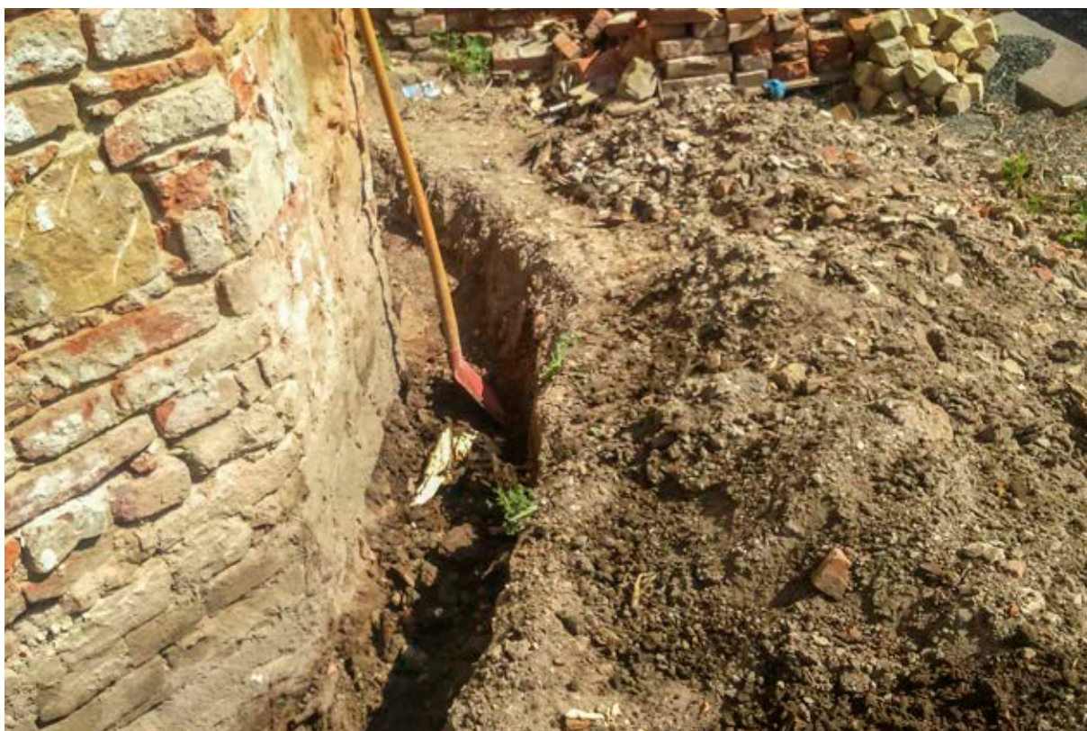
Odkryté základy vnějšího pláště kaple
