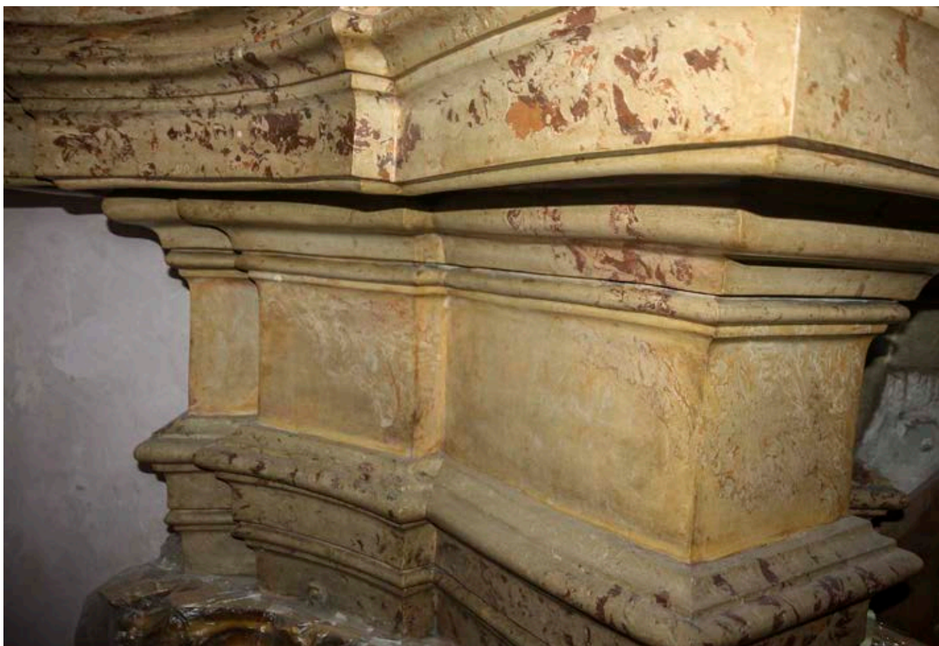
Mramorovaná oltářní římsa (stav po dokončení restaurování)
