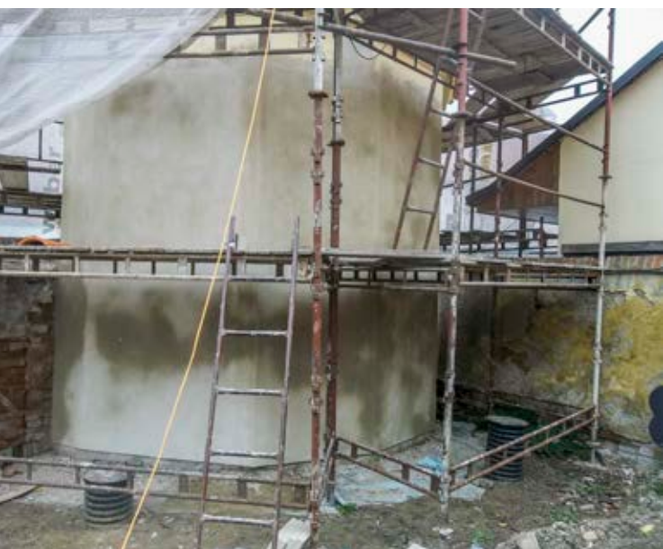
Vápenná jádrová omítka vnějšího pláště
