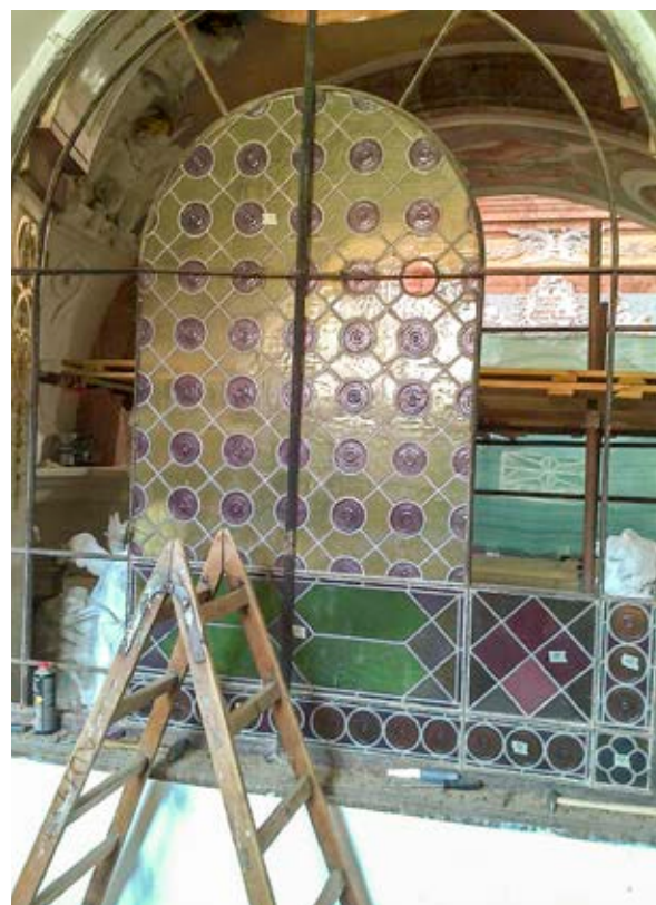
Demontáž vitráže Prázdný rám vitráže
