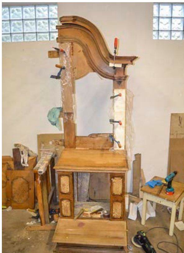
Zpevňování konstrukce zpovědnice
