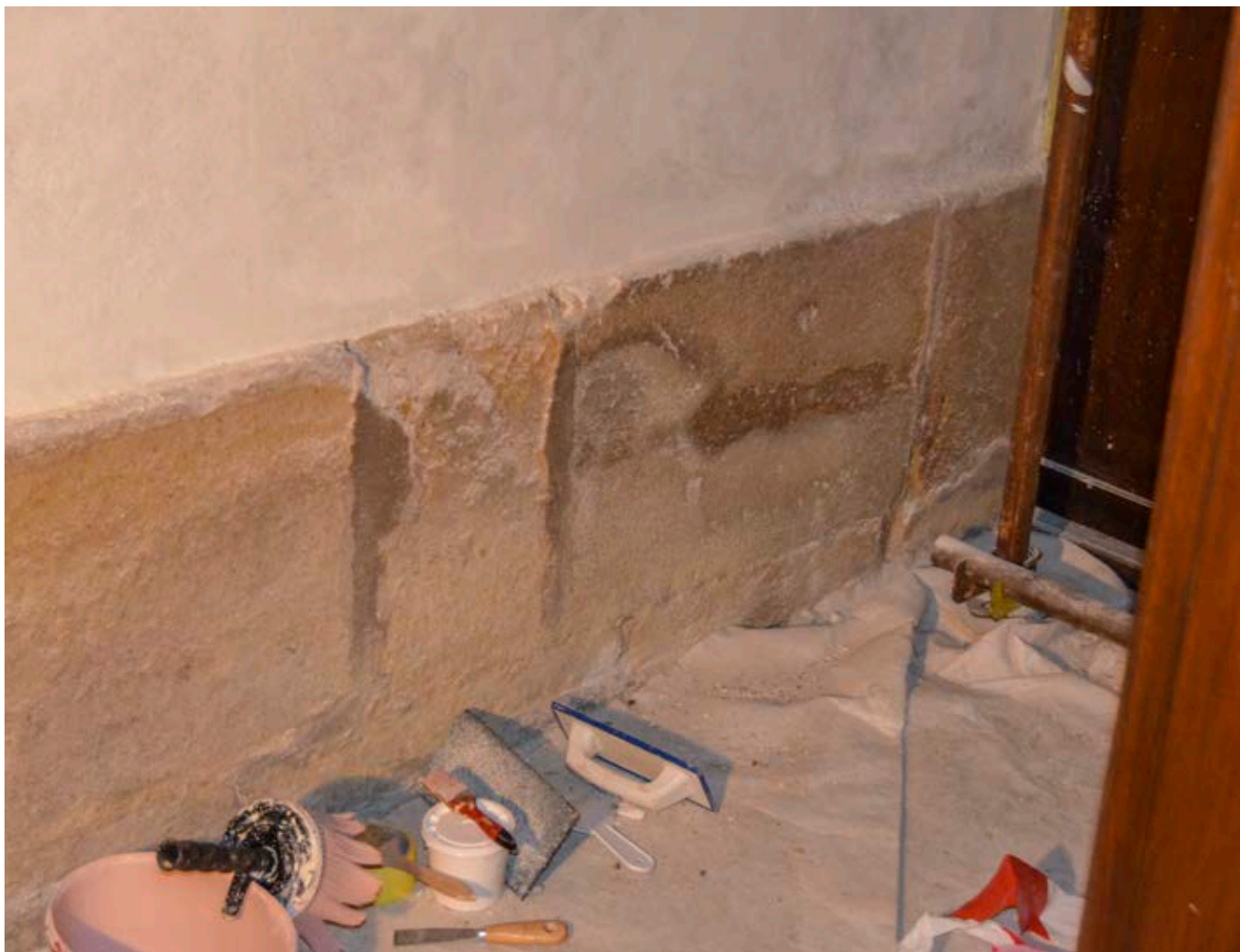
Degradované části pískovcového soklu
