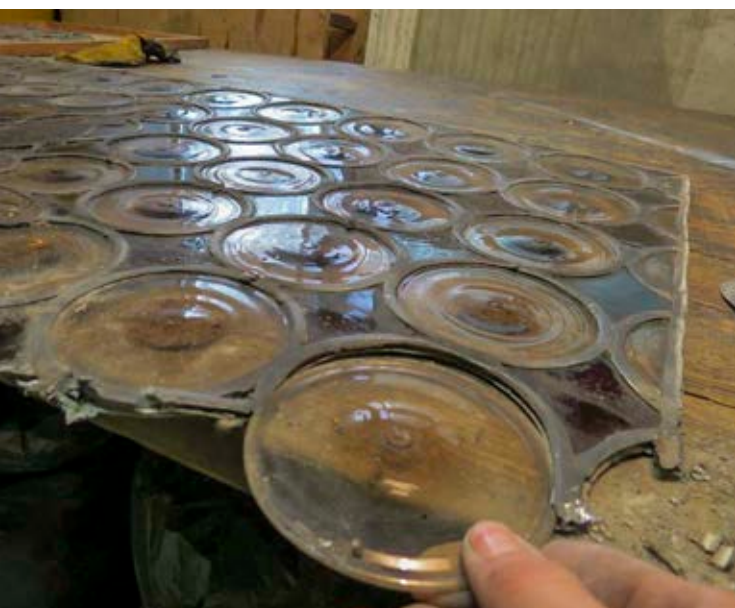
Vyjímání skleněných segmentů z olověné sítě
