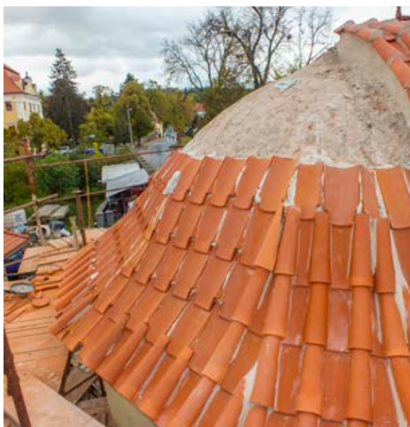
Detail kladení krytiny střechy a attiky
