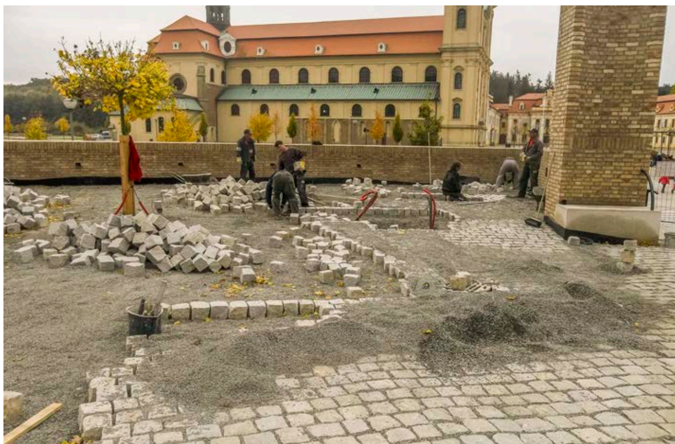
Dláždění ploch hlavního vstupu do areálu
